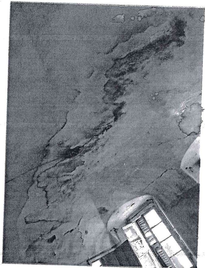
FESSURAZIONE SOFFITTO
